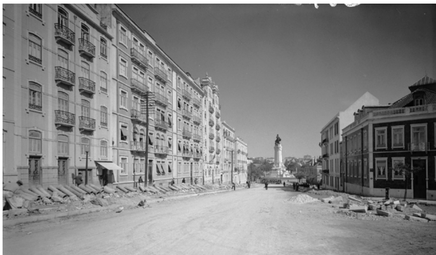
Obras de pavimentação na rua Braamcamp 1946-07 | PT/AMLSB/CMLSBAH/PCSP/004/FEC/000111 | © Arquivo Municipal de Lisboa
